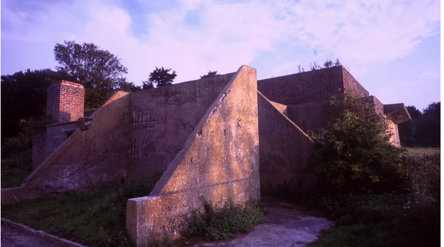
Bawdsey Transmitter Block
