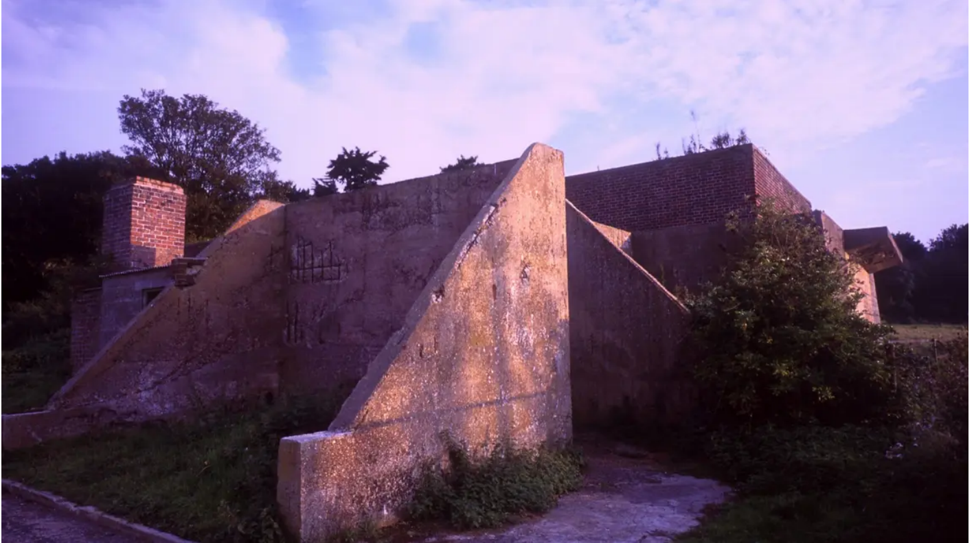
Bawdsey Transmitter Block
