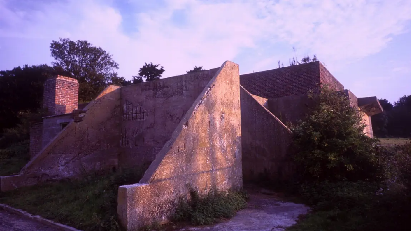
Bawdsey Transmitter Block
